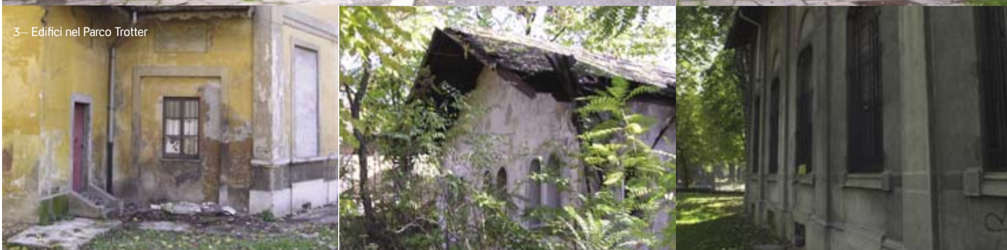
4- Scuderia dei Montel di via Fetone
